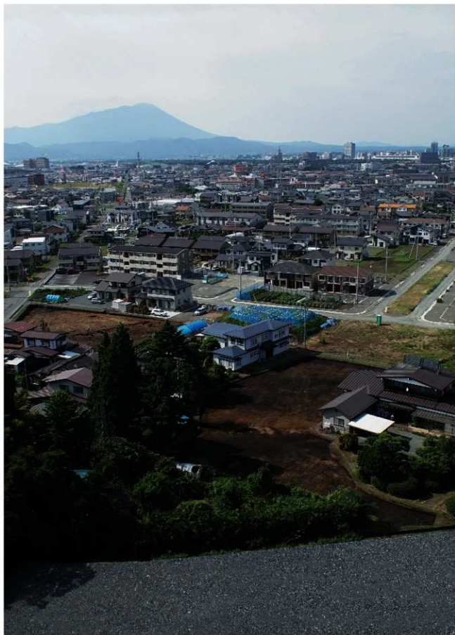
第37次調査Ⅰ・Ⅱ区全景（南西から）
