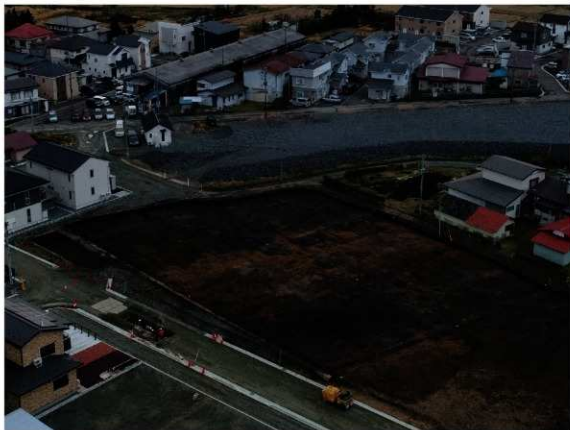
第 37 次調査Ⅲ区全景（北西から）
