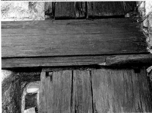
(2) 縦樋・横樋直交部 (南東から)
