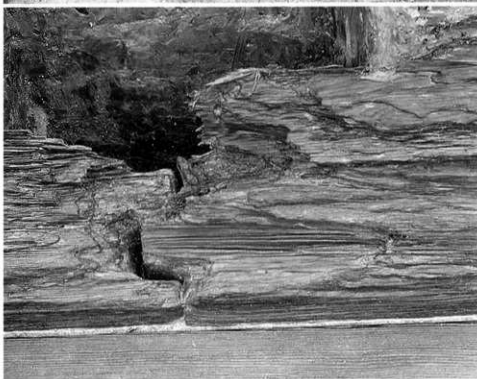
(2) 側板接合状況
