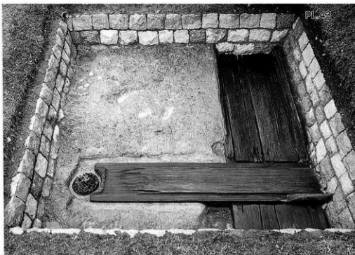
(1) 取水口全景 (南東から)
