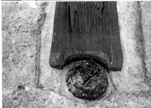
(3) 横樋西側端部 (南東から)
