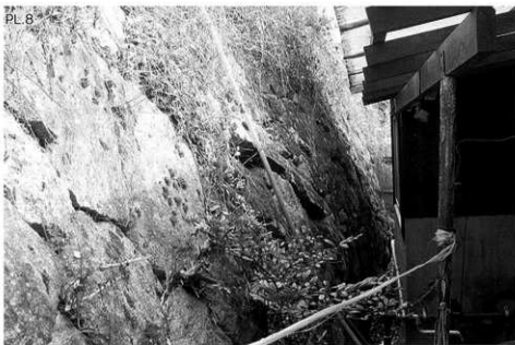
(1) 石垣1南面半み状況 (南西から)
