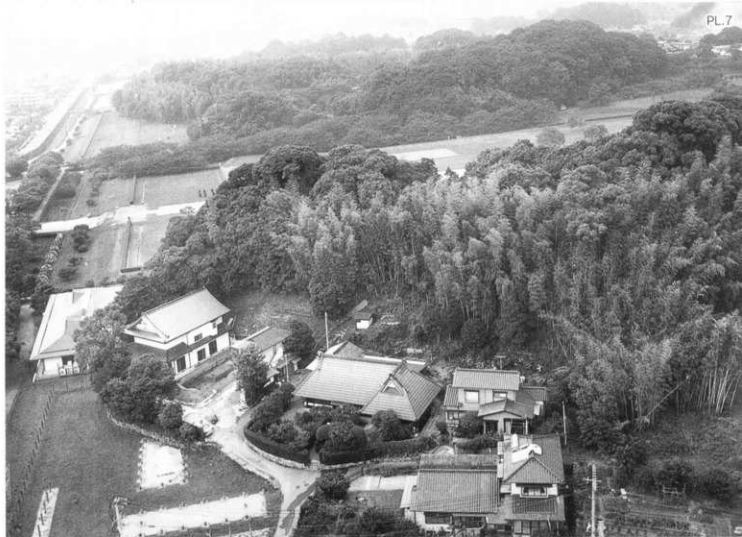
(1) 第191次調査区遠景(気球写真・東上空から)
