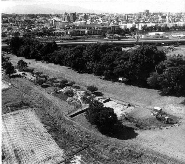
(2) 同上 (空中写真) (南から)
