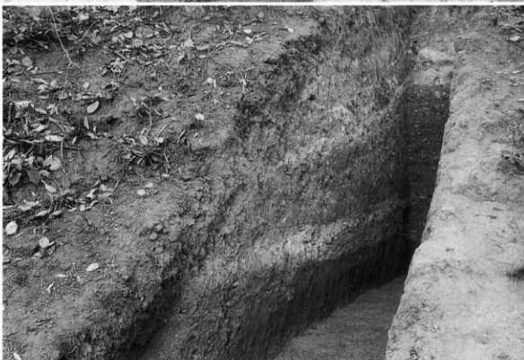
(2) 土塁盛土 Tr. 10西壁 (東から)
