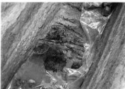
Fig.116 敷粗朶工法跡（粗朶の一部が炭化）
