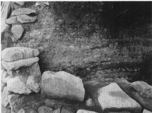
石垣SA115背面版築土層 (北西から)
