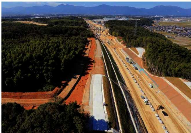
第6次調査（東から）
