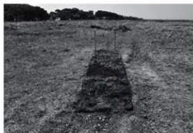
2 トレンチ8 埋め戻し完了 東から
