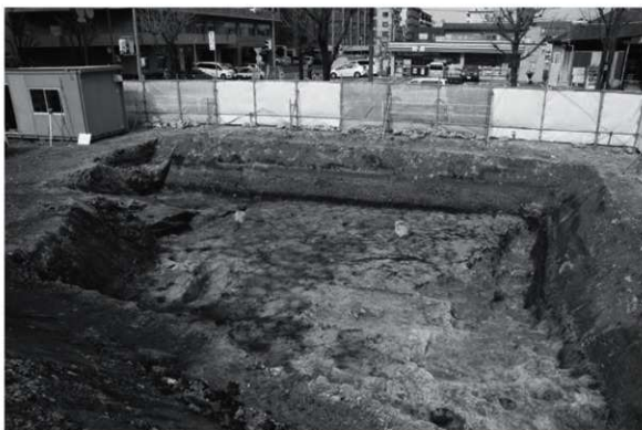
Ph2 調査第2区全景（南から）
