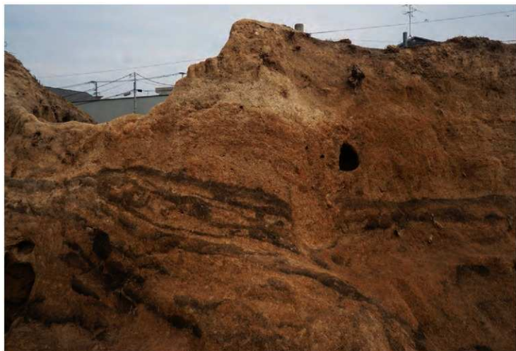
(2) 土壘縦断面土層中央部分 (南から)
