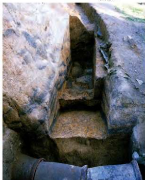
(2) 縦断面サブトレンチ (西から)
