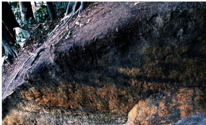
(1) 1トレンチ土壁前面上部東壁（西から）
