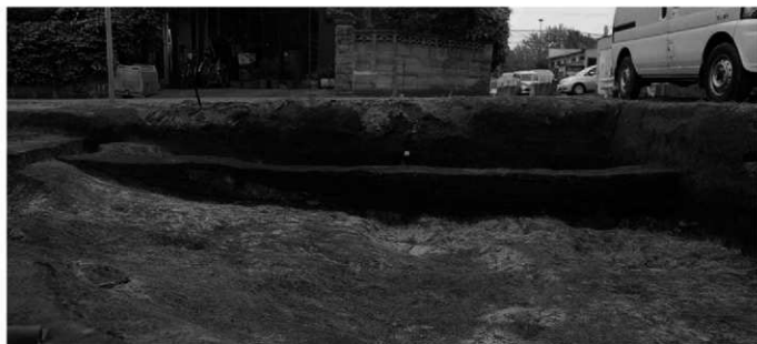
(3) 1号溝 B-B' 断面土層 (南西から)
