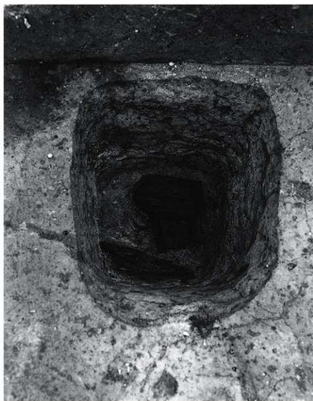
(2) P1 礎板様出状態 (北から)
