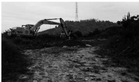
3. 掘削風景 (北より)
