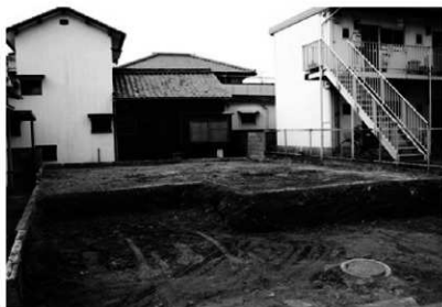
1. 調査前風景 (北より)
