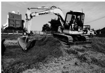
2. 重機による掘削状況 (南より)
