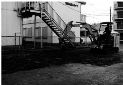
3. 調査区 埋め戻し状況 (南東より)
