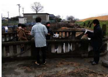
外観だけを残す江南サイフォン（熊谷市川原明戸）
