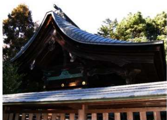
埼玉県指定文化財「上之村神社本殿」「雷電神社本殿」(写真)銅瓦葺の美
