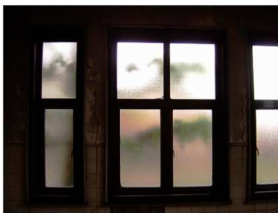
内壁における亀裂
