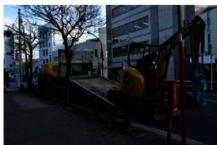
8. 重機搬入作業状況
