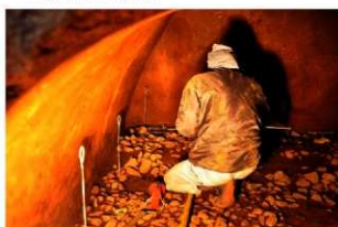
6. 断面実測作業状況
