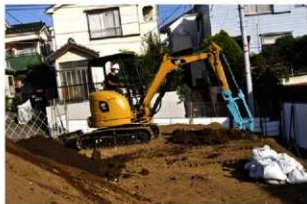
1. 機械掘削作業状況
