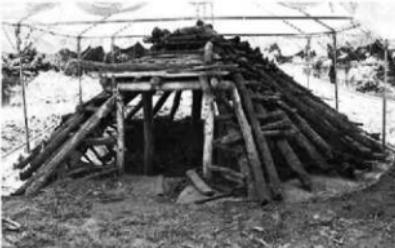
屋根土の除去後、劣化状況を確認しながら屋根材や柱などを解体し、埋め戻しました。今年度に加工した屋根材・柱材等を使って、次年度に土屋根を復元する予定です。
