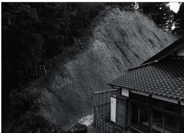
調査区東側斜面断面（北東から）
