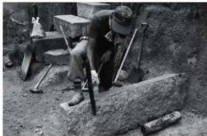
写真7 ツルハシを使った粗削り作業(高畠石)
