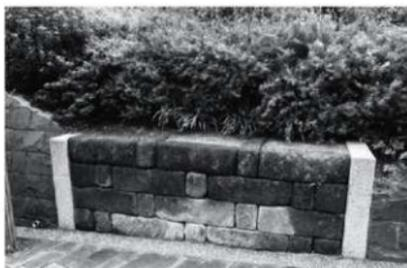
写真2 横浜山手のフランドル石積みの模型
