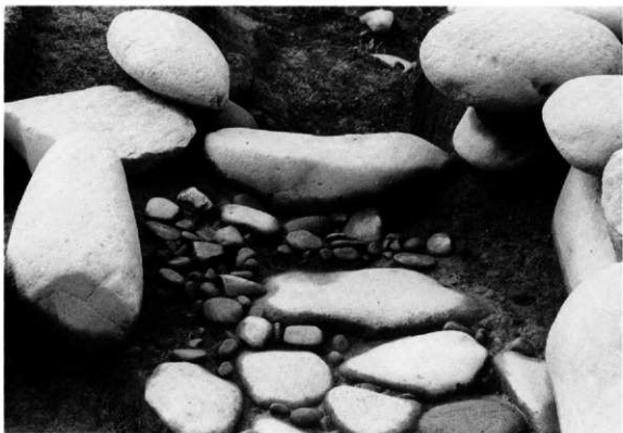
2. 3区2号填石室仕切部
