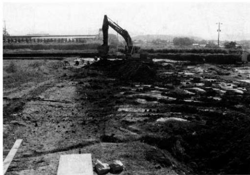
徳永川ノ上遺跡表土剥ぎとり作業
