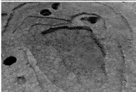
3) 同上 浮き石をはずした状態
