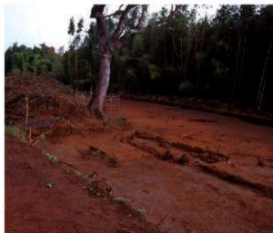
(3) 南区中央部（南西から）
