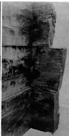
4. 井戸枠組目の状況a
