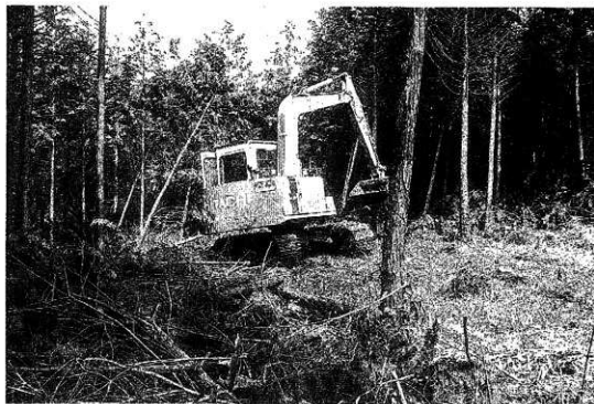
重機による表土剥ぎ
