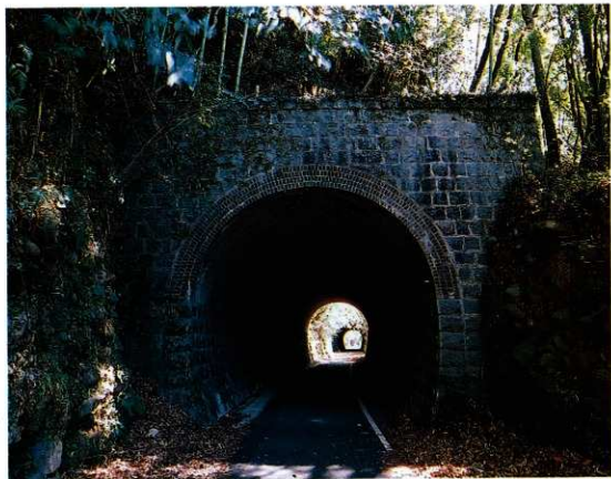
厚ヶ瀬トンネル
