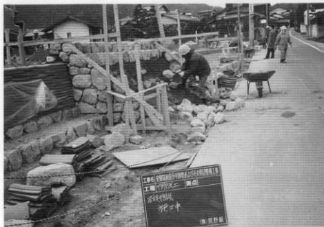
(2) 塔跡基壇南側石組階段工事
