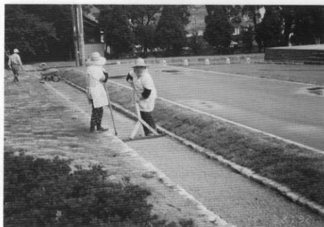
(1) 回廊跡雨落溝砂利敷状況
