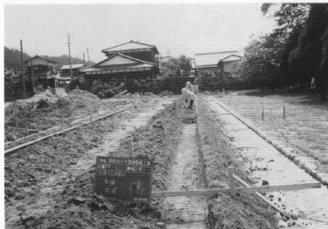
(4) 回廊跡基壇縁石据付床掘り状況
