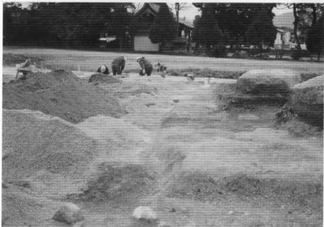
(4) 塔跡盛土工事状況 (洗砂使用)
