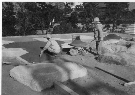
(1) 塔跡基壇表層土壌固化舗装状況
