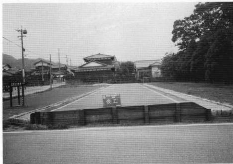
(4) 南面回廊整備後
