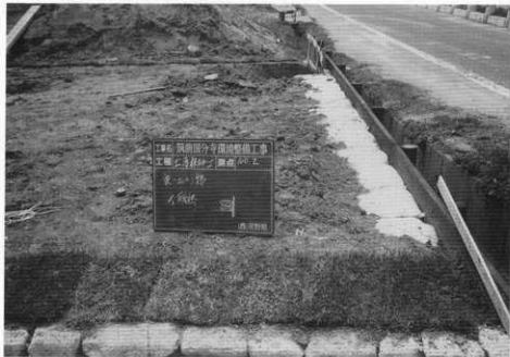
(3) 回廊基壇土留板欄工事
