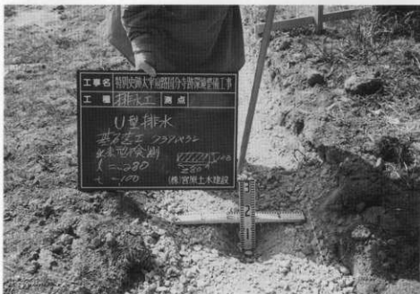
(2) 排水溝付設路盤工事
