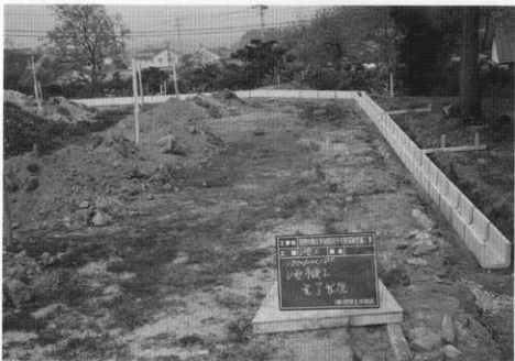
(4) 排水溝付設状況
