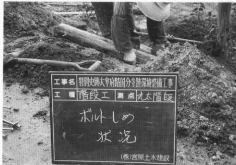
(3) 講堂跡東側丸太階段据付工事
