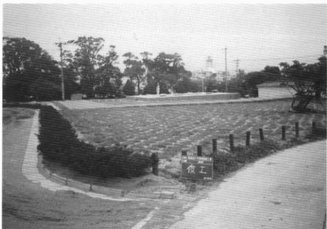
(4) 北面回廊北側整備後
