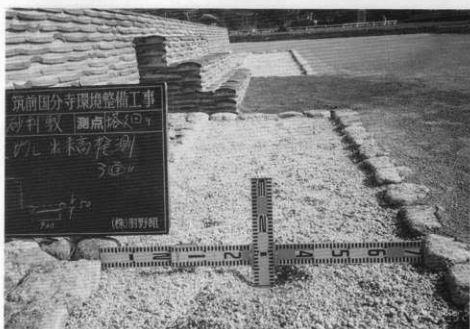
(2) 塔跡雨落溝砂利敷状況
