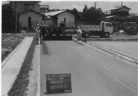
(2) 回廊跡基壇脱色アスファルト舗装工事
