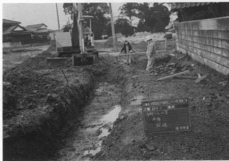
(1) 水路改修暗渠排水工事
