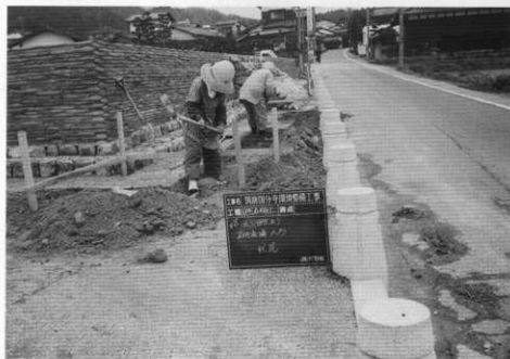
(1) 塔跡雨落溝床掘り状況
