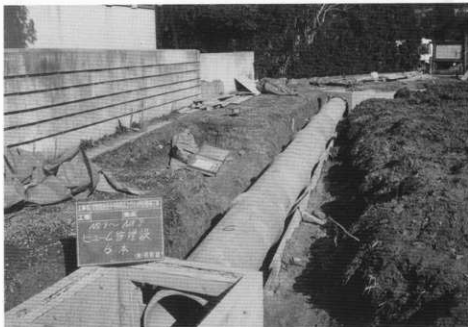
(3) 暗渠排水ヒューム管理状況
