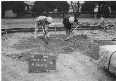
(3) 塔跡模造礎石据付床掘状況
