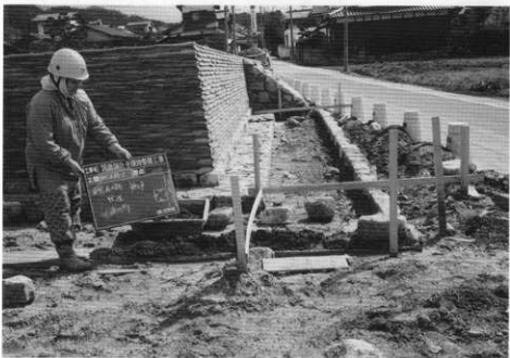
(4) 塔跡雨落溝石積み状況
