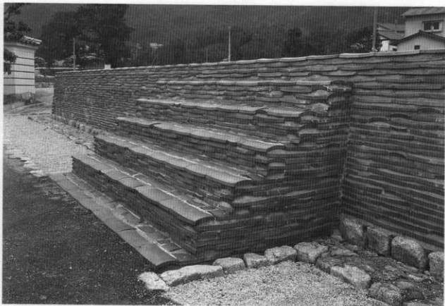
(2) 整備後の塔跡西側瓦積み階段
