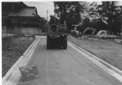
(4) 園路土壌固化舗装上層工事
