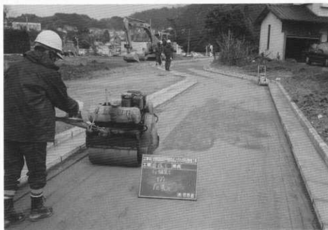
(3) 園路土壌固化舗装下層工事
