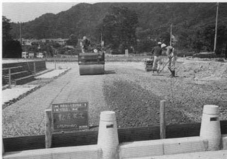
(1) 回廊跡内側路盤工事
