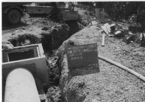
(2) 水路改修暗渠排水工事
