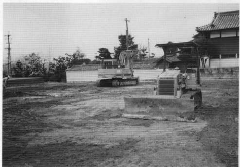
(2) 整地工事状況
