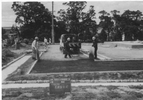
(3) 回廊跡基壇舗装プライムライト乳剤散布状況
