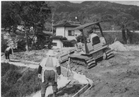
(2) 法面整地工事
