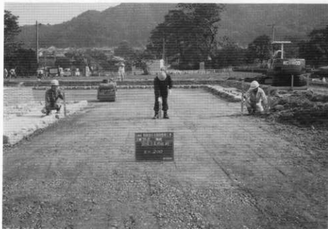
(4) 回廊跡内側整地状況
