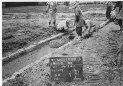
(2) 回廊跡雨落溝床コンクリート打設状況
