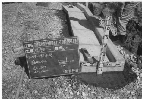
(1) 園路L型側溝付設状況
