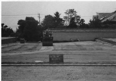
(4) 回廊跡内側土壌固化舗装転圧状況
