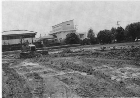
(2) 僧房跡推定地整地工事
