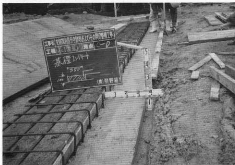
(3) 塔跡基壇基礎コンクリート打設
