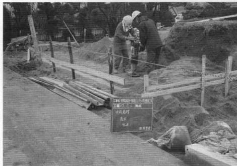
(1) 塔跡盛土転圧状況
