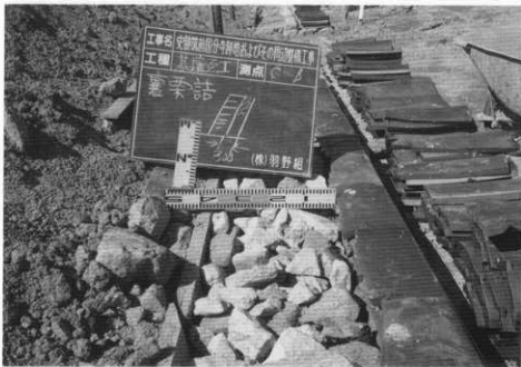
(3) 塔跡基壇瓦積み状況
