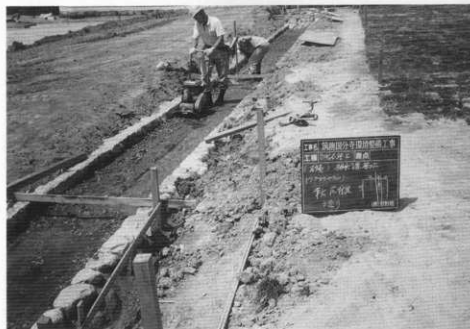
(1) 回廊跡雨落溝床路盤工事
