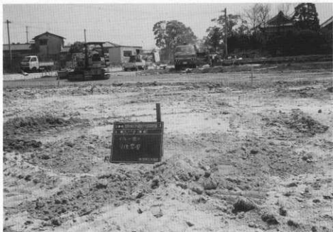
(3) 僧房跡推定地整地工事
