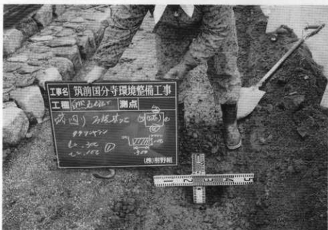
(2) 塔跡雨落溝石積み基礎工事
