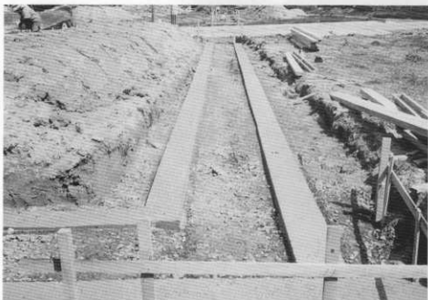
(2) 回廊跡雨落溝石積み基礎
