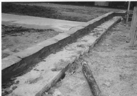
(1) 塔跡基壇瓦積み状況
