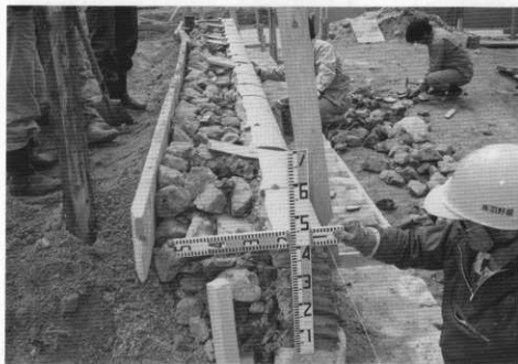
(4) 塔跡基壇瓦積み状況
