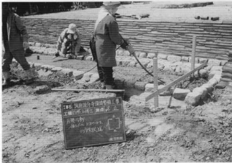
(2) 塔跡雨落溝床コンクリート打設状況
