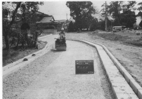
(2) 園路路盤工事転圧状況
