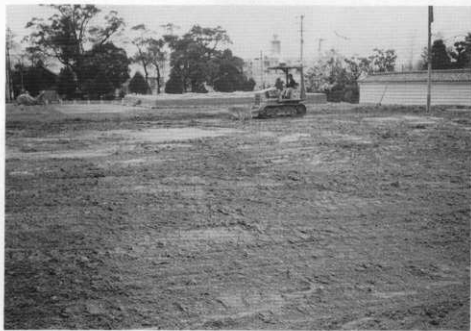
(1) 整地工事状況
