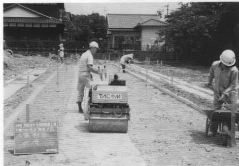
(1) 回廊跡基壇土盤整備状況
