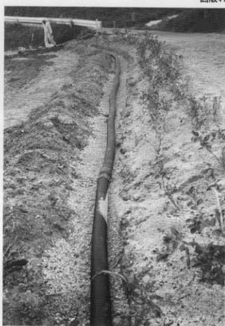
(3) 講堂跡東側暗渠排水管付設狀況
