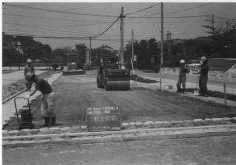
(2) 回廊跡内側路盤工事
