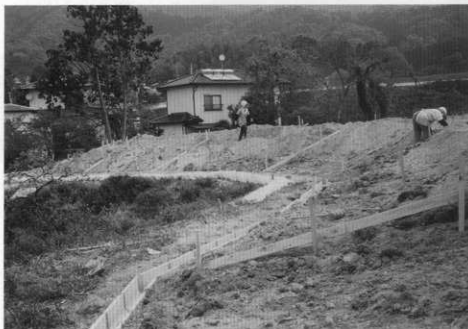
(1) 法面整地工事
