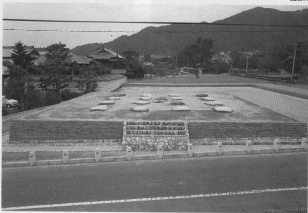
(1) 整備後の塔跡 (南から)
