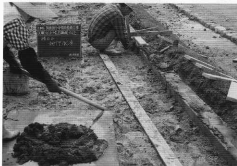
(4) 回廊跡基壇縁石据付け状況
