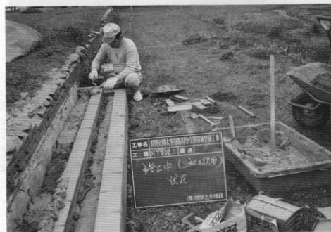
(2) 講堂跡瓦積階段修理工事
