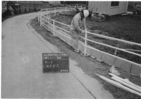
(3) ガードパイプ付設状況
