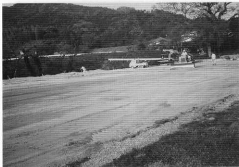
(4) 僧房跡推定地整地工事
