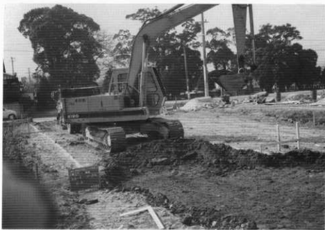
(3) 園路路盤工事
