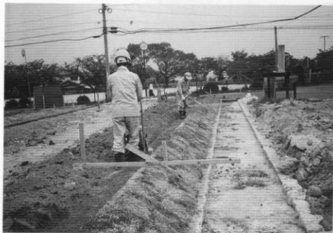
(1) 回廊跡基壇縁石据付け路盤工事
