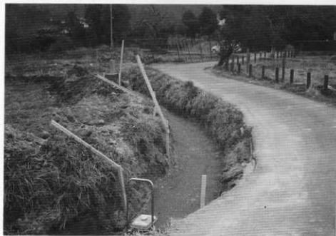
(1) 水路改修路盤工事
