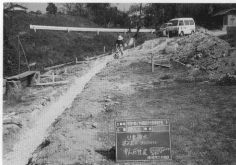
(1) 排水溝付設路盤工事
