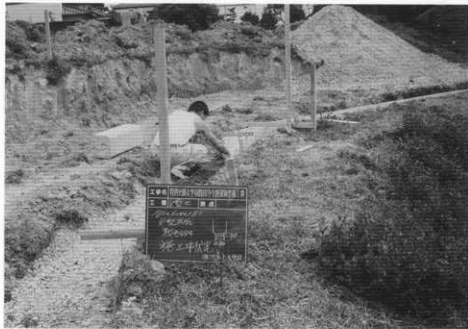
(1) 排水溝付設工事
