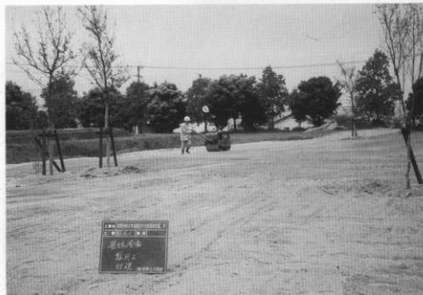
(1) 僧房跡推定地植栽状況
