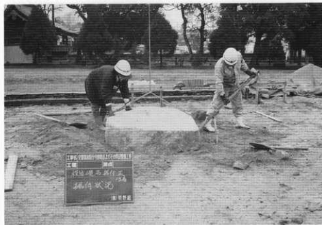
(4) 塔跡模造礎石据付状況
