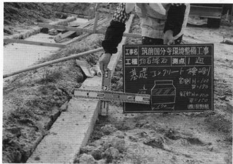
(3) 回廊跡基壇縁石据付け基礎工事
