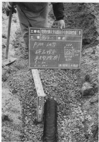
(4) 講堂跡東側暗渠排水工事
