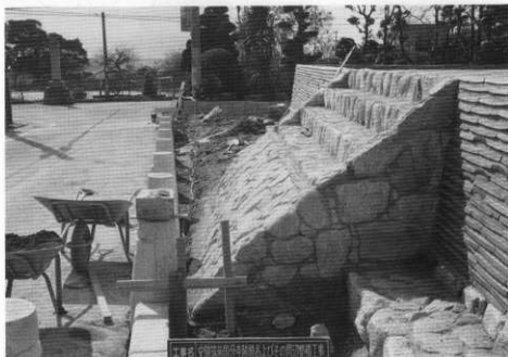
(4) 車止め石柱設置状況
