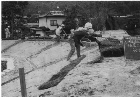
(3) 法面張芝工事
