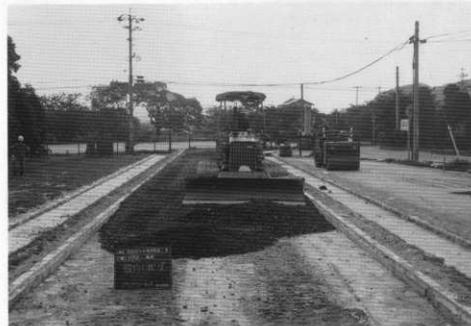
(2) 回廊跡基壇路盤工事
