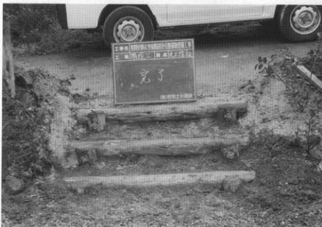
(4) 講堂跡東側丸太階段据付状況
