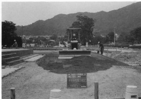
(3) 回廊跡内側土壌固化舗装工事
