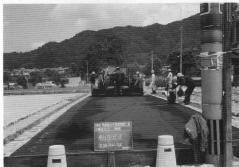
(4) 回廊跡基壇舗装工事
