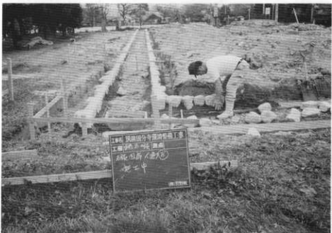
(4) 回廊跡雨落溝石積み状況
