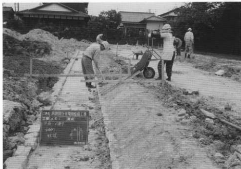
(3) 回廊跡基壇法面工事
