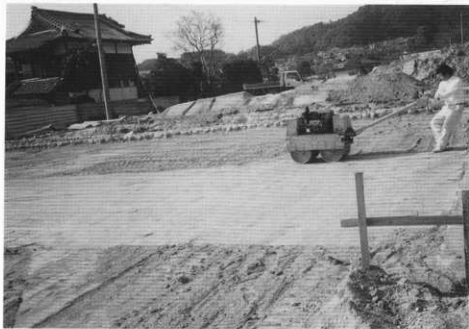
(3) 回廊跡内側整地転圧状況
