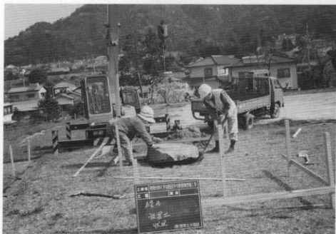
(1) 講堂跡礎石据付工事
