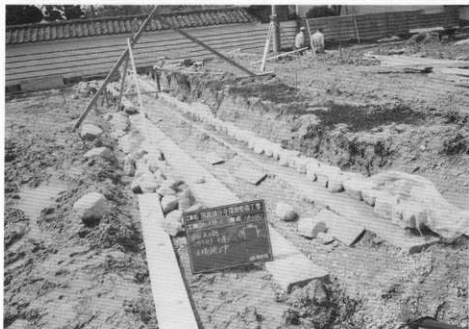
(3) 回廊跡雨落溝石積み状況
