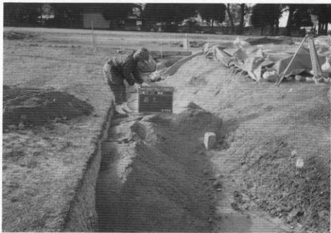
(3) 塔跡盛土工事状況
