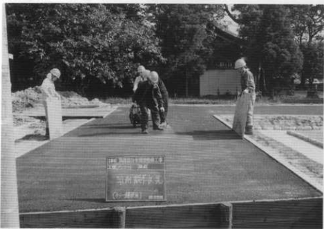
(1) 回廊跡基壇アスコン舗装表層乳剤散布状況
