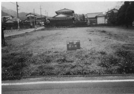
(3) 南面回廊整備前
