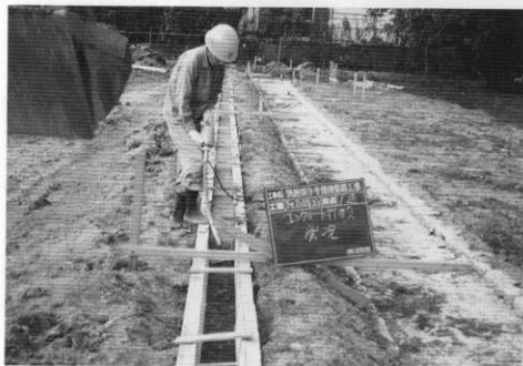
(2) 回廊跡基壇縁石据付け基礎コンクリート打設状況
