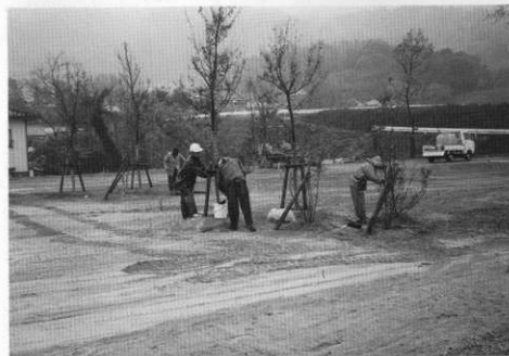
(2) 僧房跡推定地植栽状況
