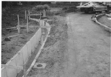
(2) 水路改修U字型側溝付設状況
