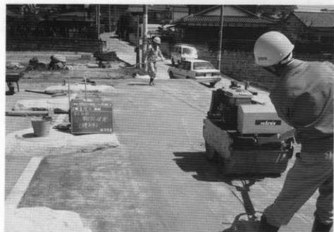
(2) 塔跡基壇表層土壌固化舗装状況
