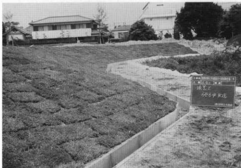
(4) 法面の張芝の状況
