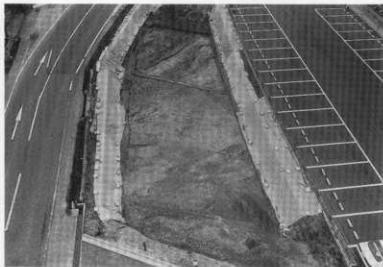
(上) I区全景 (西から)
