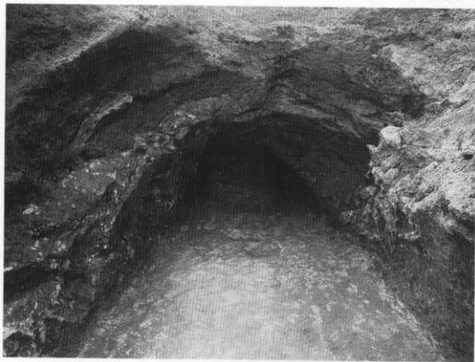
1. 4号窟跨天井部补修状况
