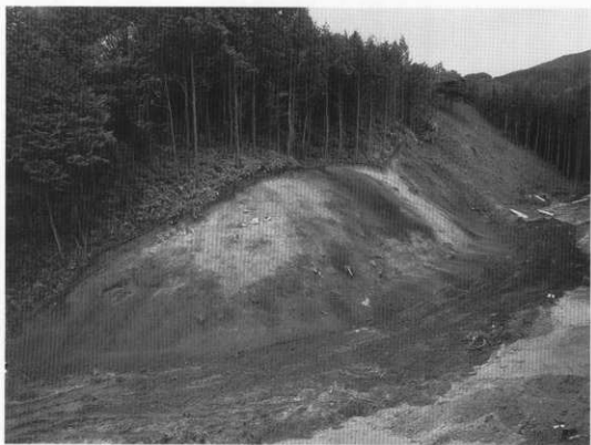
2. A-2地区裾部確認調査状況(北から)
