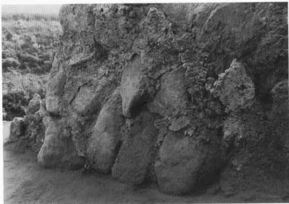
1. 36号窯 燃燒部左側石組 1
