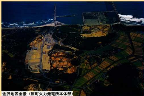
金沢地区全景（原町火力発電所本体部）
