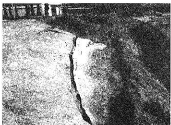
H 2 10号溝完掘状況
