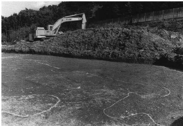
(1) 1-Ⅱトレンチ土層堆積状況
