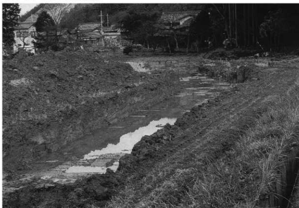
(2) 11 トレンチ完掘状況
