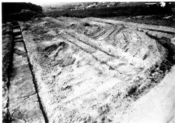
(2) O~R区 南半調査後の状況(北東より)
