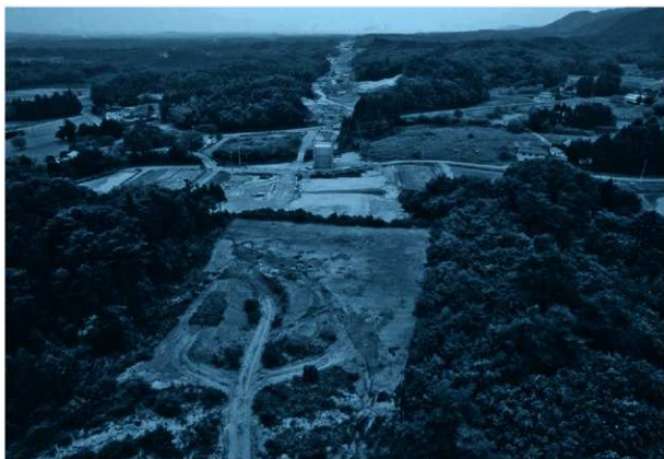
2 調査区全景（北から）
