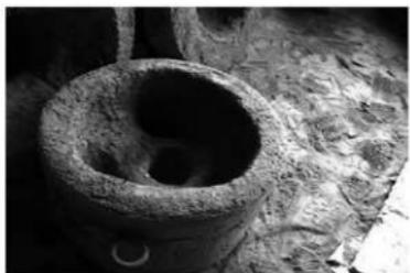
図 80 下地の荒真土を張り付ける
