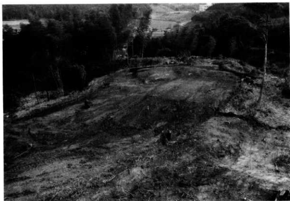
2. 同 中央区（表土除去後）〔北から〕
