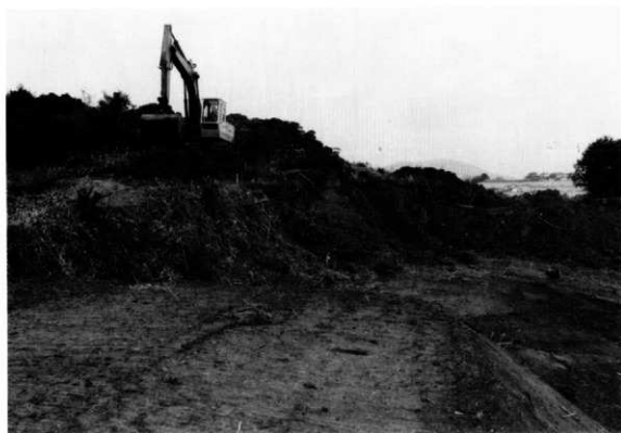
2. 同 西側の表土除去作業〔南東から〕
