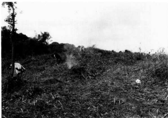
1. 山田沖古墳群中央区西側の伐開作業〔南東から〕
