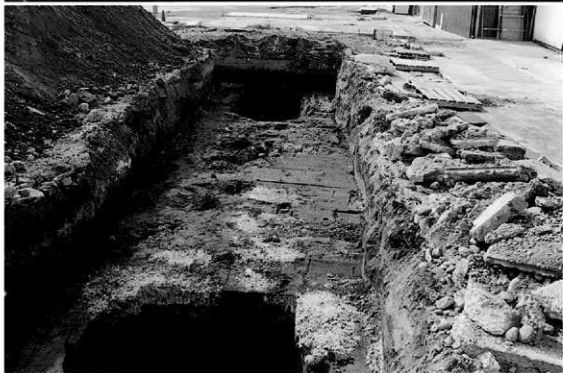
3 10-2トレンチ (南西から)
