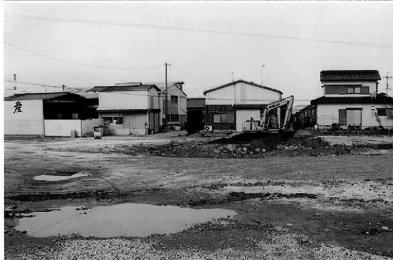
3 高浜番所跡 平成10年度調査地 掘削状況（西から）
