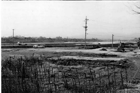
2 高浜番所跡 平成10年度調査地 全景（北から）
