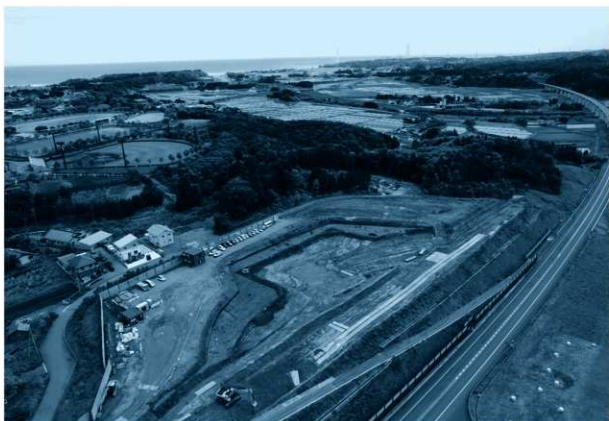
1 遺跡遠景（北西から）
