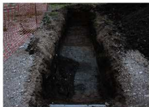
写真3 中津城下町遺跡40次調査Aトレンチ（南から）
