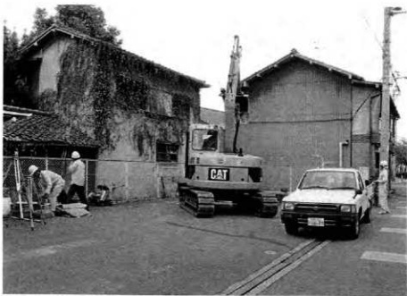
調査地近景 (南東から)
