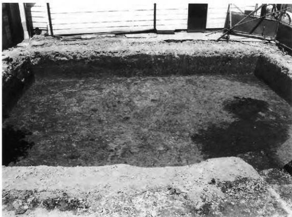
調査地全景(南から)
