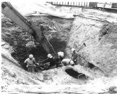
第3層掘削状況 (東から)
