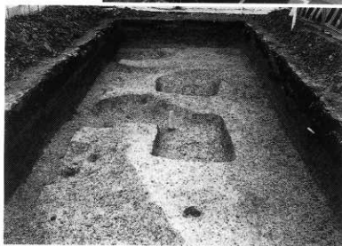
調査区完掘状況 (北から)
