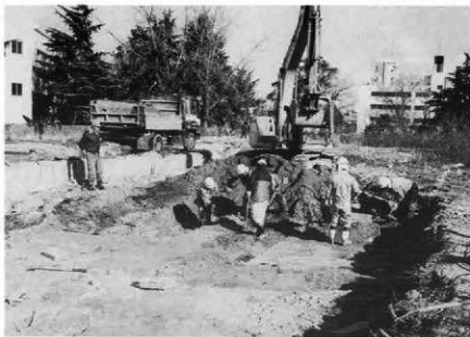
機械掘削時の風景 (西から)
