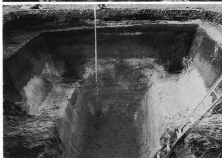
最終掘削状況 (南から)
