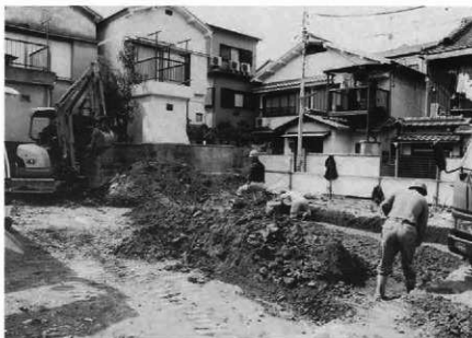
調査開始時の状況 (北東から)
