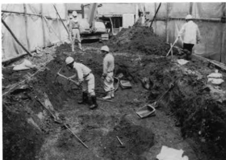
機械掘削状況 (南から)
