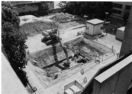
調査地全景 (北西から)
