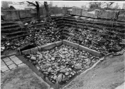
Ⅲ区石垣裏込検出状況 (南東から)
