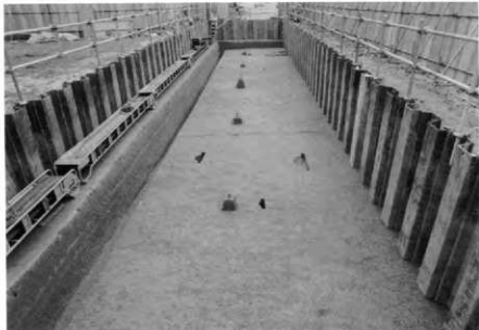
第7層上面検出遺構 (東から)
