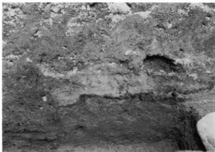
調査区北壁断面 (南から)
