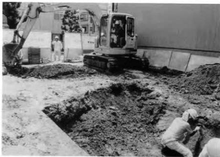
機械掘削状況 (北西から)
