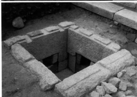
I区会所および暗渠完掘状況 (北東から)
