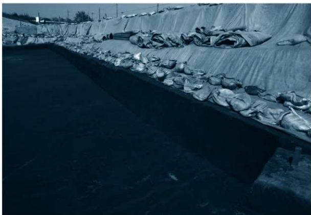
2 調査⑤中区基本土層（南西から）
