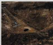
写真 61 SE03 標高 5,000 m 地点まで掘削
