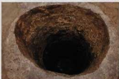
写真 64 SE03 標高 5,000 m 地点での完掘
