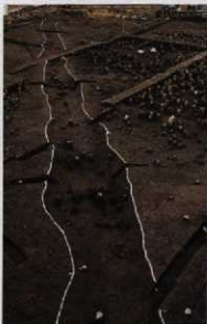
写真97 SD32路床完備
