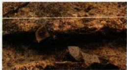
写真 46 SK146 被熱床下断ち割りアップ
