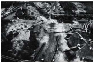
11・12 地区 つなぎ箇所 南から
