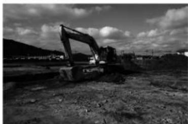
重機による表土除去作業
